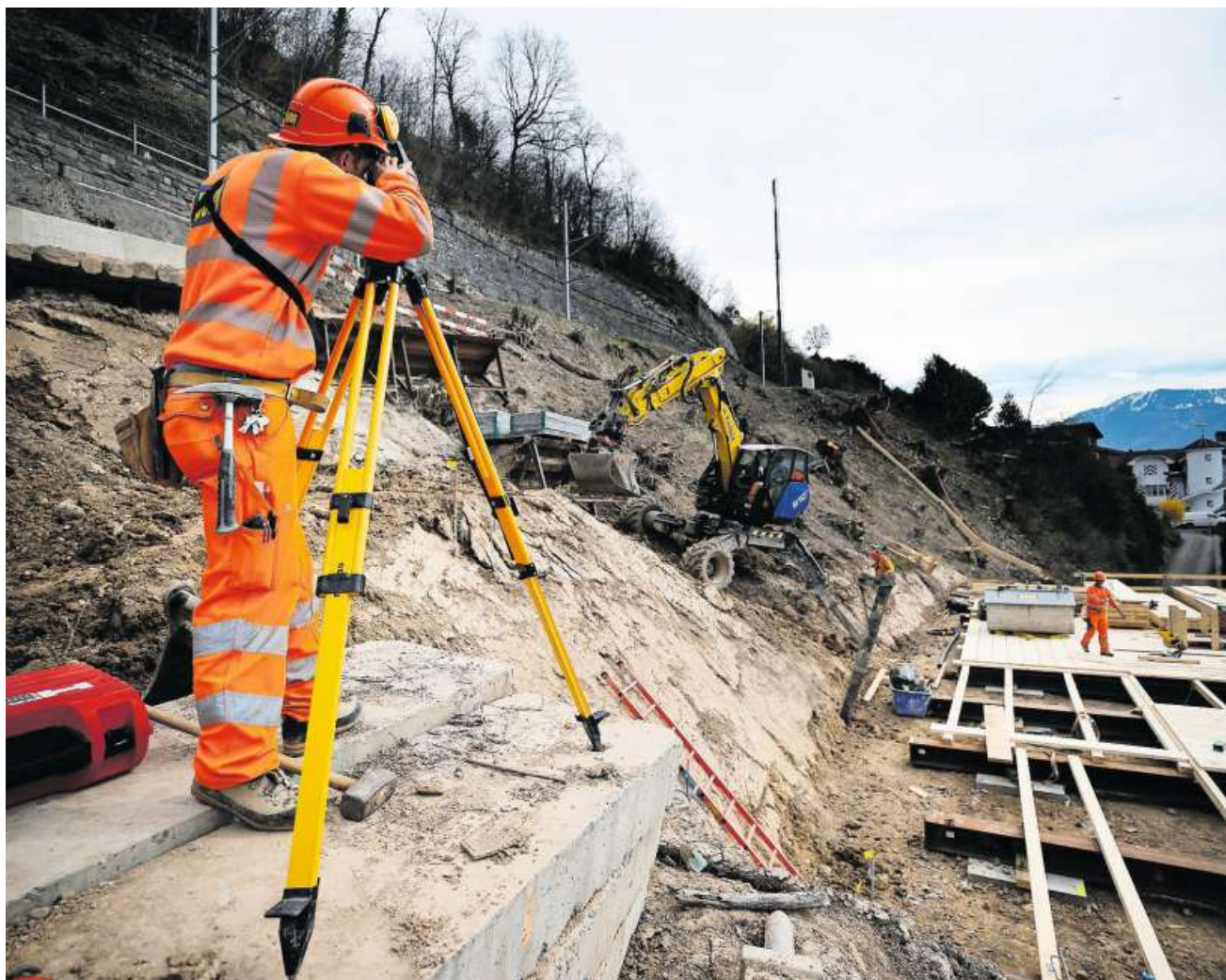
In Walchwil wird zwischen Lothenbach und Hörndli ein Installationsplatz gebaut.
